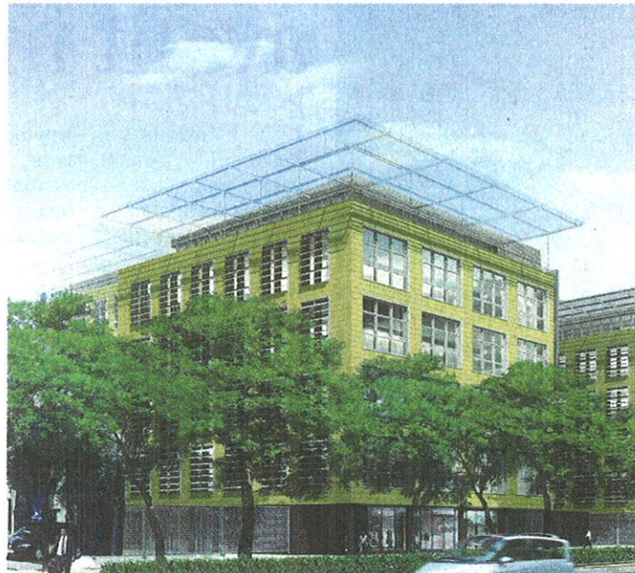
CE BÂTIMENT DE BLATON, à Forest, est précurseur en matière de faible consommation énergétique. © D.R.
