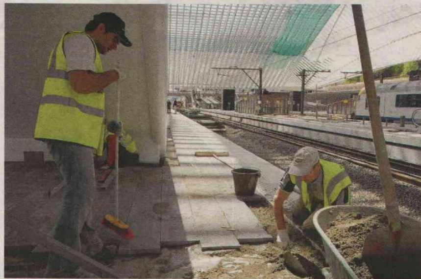
Sur les quais, on a posé la pierre bleue bouchardée wallonne de 4 centimètres d'épaisseur. ■ C.FERON
