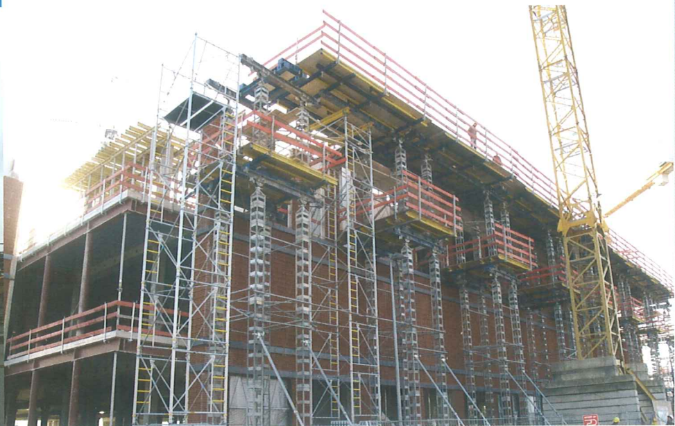
Chantier du Président au Kirchberg
