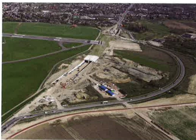
Om de creatie van een verplichte obstakelvrije veiligheidszone mogelijk te maken, wordt de R11 (Krijgsbaan) vlak achter de start- en landingsbaan van Antwerp Airport ondertunneld.
